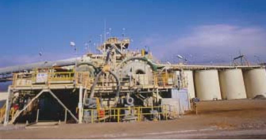
Öğütücülerin, karbon adsorpsiyonunun ve siyanür liçinin gerçekleştirildiği bölüm.
