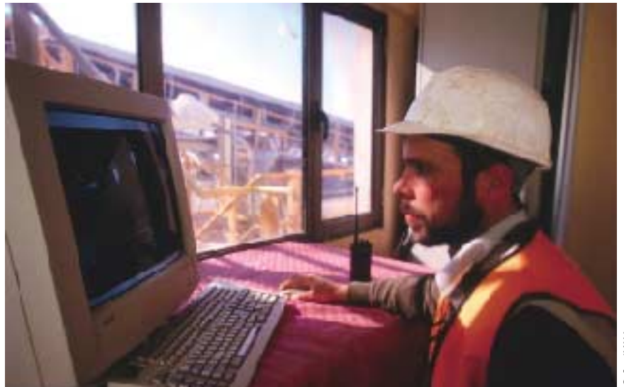
Tesisteki tüm işlemler, PLC bilgisayar ünitesine bağlı bir sistem aracılığıyla izleniyor.
